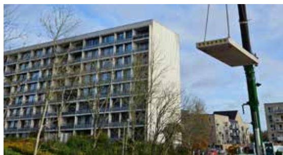
Specielt at se et genbrugshuldæk foran en af de bagvedliggende blokke hvor den oprindeligt kom fra, blive anvendt i nyt byggeri.
