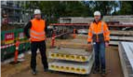
Der indbygges genbrugte betonhuldæk fra Gjellerup i nye boliger i Gjellerup
