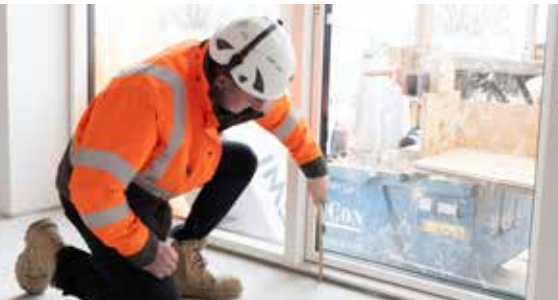
Tilgængelighed for alle skal sikres gennem såvel projektering som udførelse. Her tjekkes opbygningen til niveau-fri adgang under udførelse.
