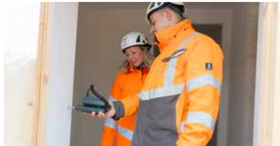
Konstruktionerne måles for fugt for at sikre et tørt og sundt byggeri.
