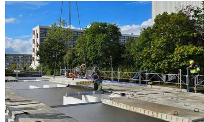
De genbrugte huldæk løftes på plads i nye fastgjorte ankre, og montageprocessen forløb derved helt uproblematisk.
