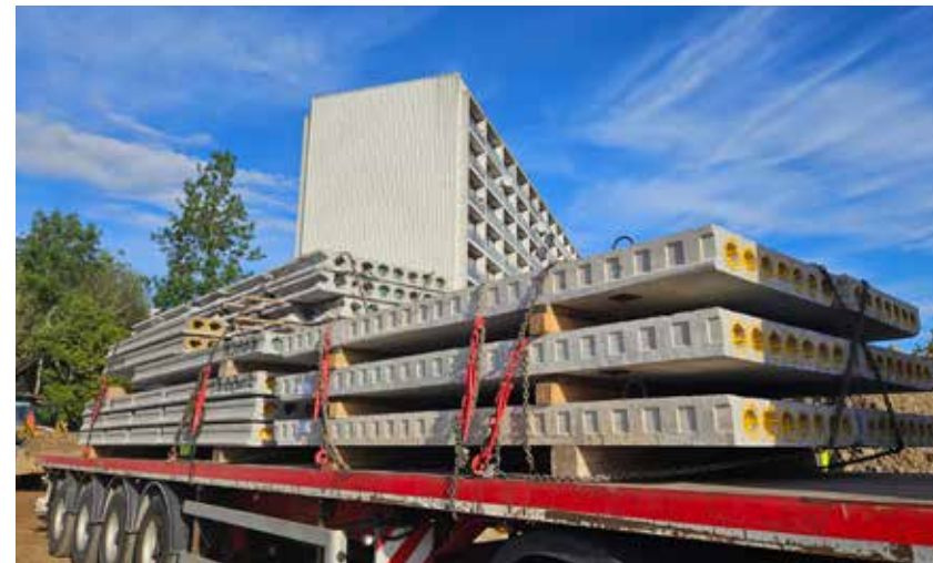
De genbrugte huldæk ankom til byggepladsen på en lastvogn sammen med nye huldæk. De gamle huldæk er utrolig god kvalitet, og de oprindelige firkantede mønstre langs siderne står stadig helt skarpt
